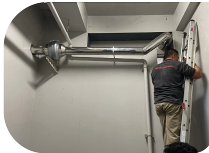
ติดตั้งตู้ดูดควัน (Fume Hood) และระบบระบายอากาศ
