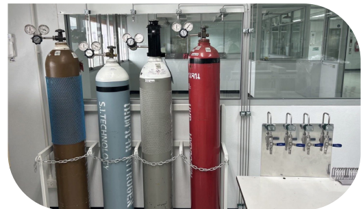
งานเดินท่อระบบสาธารณูปโภคและท่ออุตสาหกรรม
