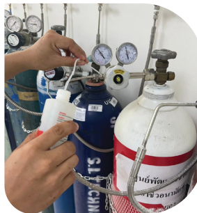
งานเดินท่อระบบแก๊สสำหรับห้องแล็บและอุตสาหกรรม
